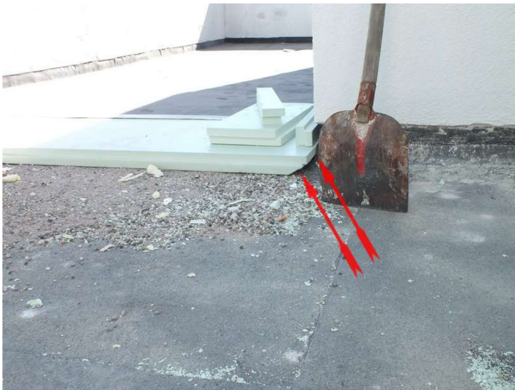
Bild 08_Gewerk Dachdecker Flachdach
