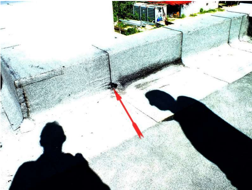
Bild 05_Gewerk Dachdecker Flachdach
