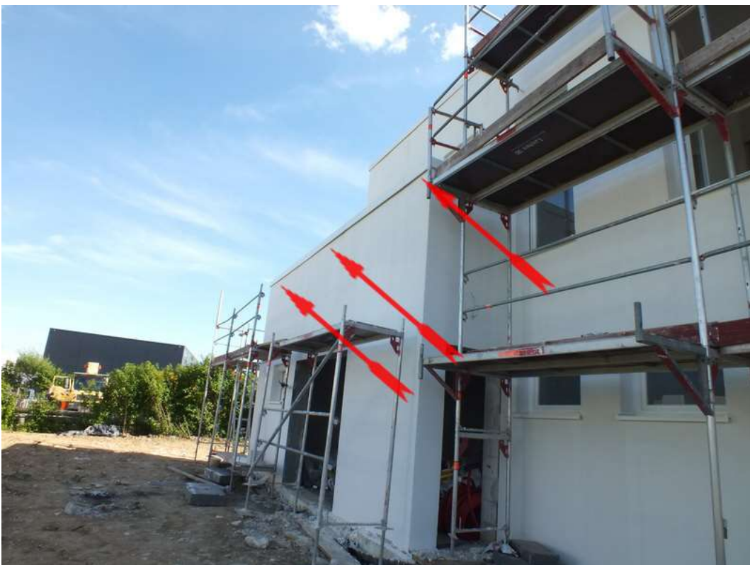
Bild 20_Gewerk Dachdecker Flachdach
