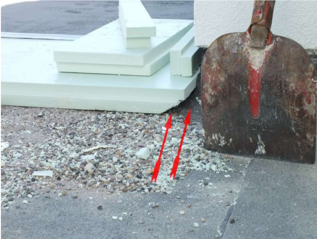
Bild 09_Gewerk Dachdecker Flachdach
