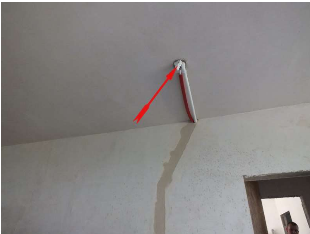
Bild 16_Gewerk Dachdecker Flachdach
