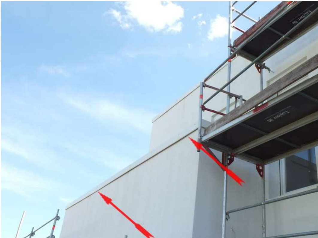
Bild 21_Gewerk Dachdecker Flachdach
