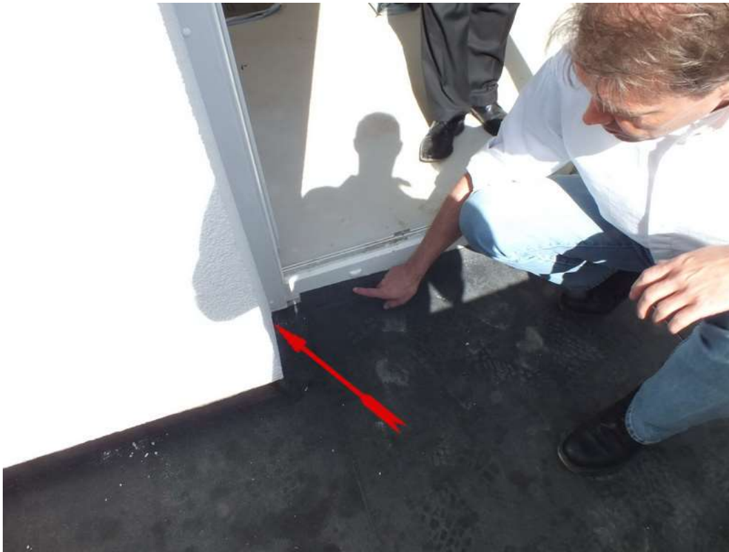
Bild 13_Gewerk Dachdecker Flachdach
