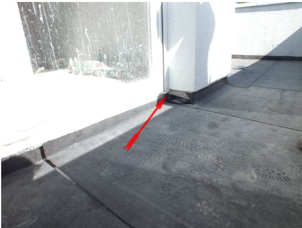
Bild 14_Gewerk Dachdecker Flachdach
