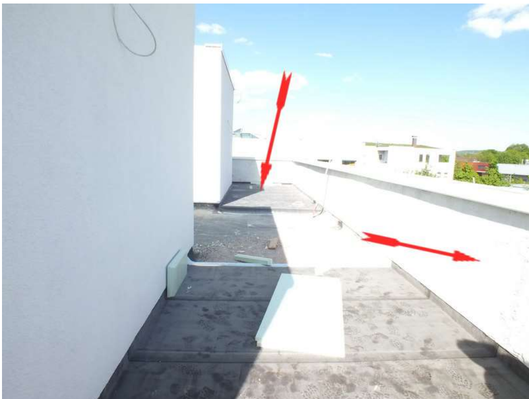
Bild 12_Gewerk Dachdecker Flachdach
