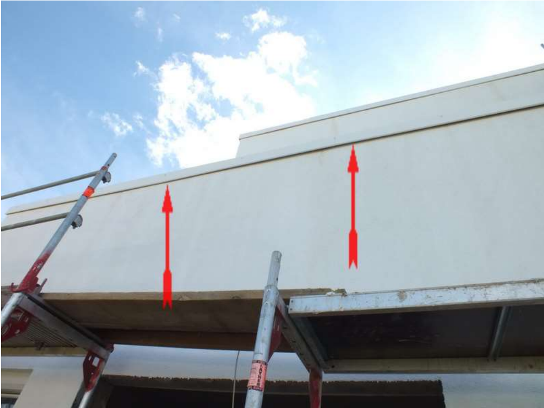
Bild 17_Gewerk Dachdecker Flachdach
