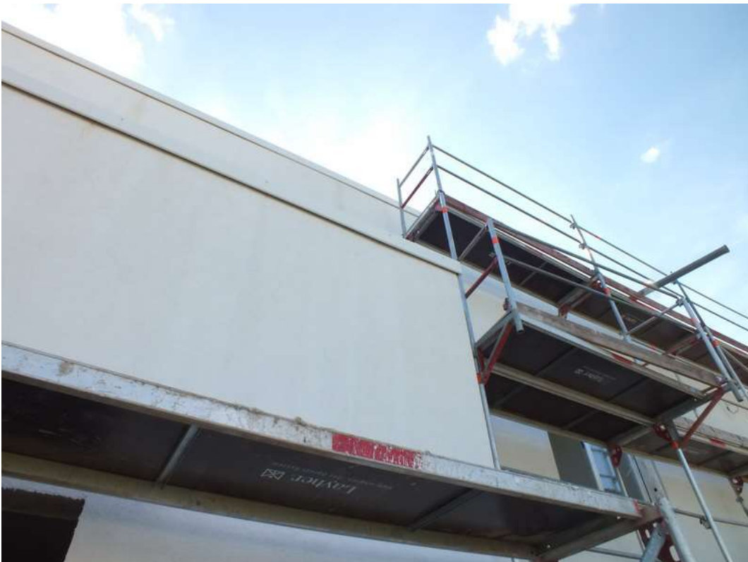
Bild 18_Gewerk Dachdecker Flachdach
