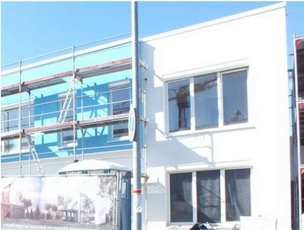
Bild 01_Gewerk Dachdecker Flachdach
