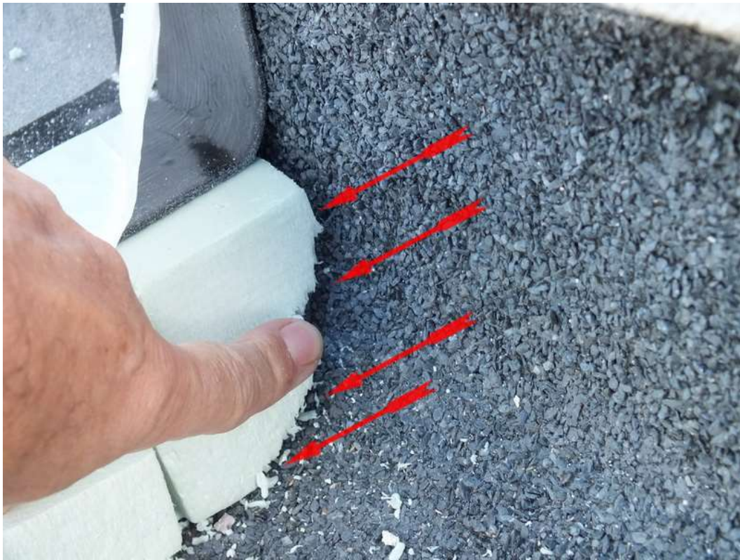
Bild 11_Gewerk Dachdecker Flachdach
