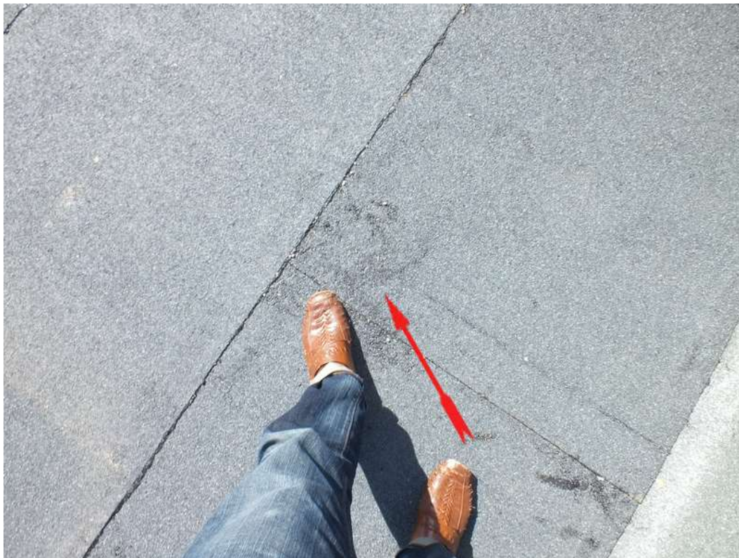
Bild 06_Gewerk Dachdecker Flachdach
