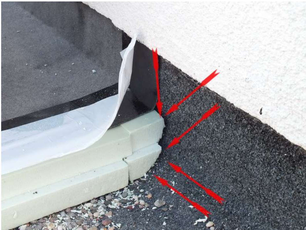
Bild 10_Gewerk Dachdecker Flachdach
