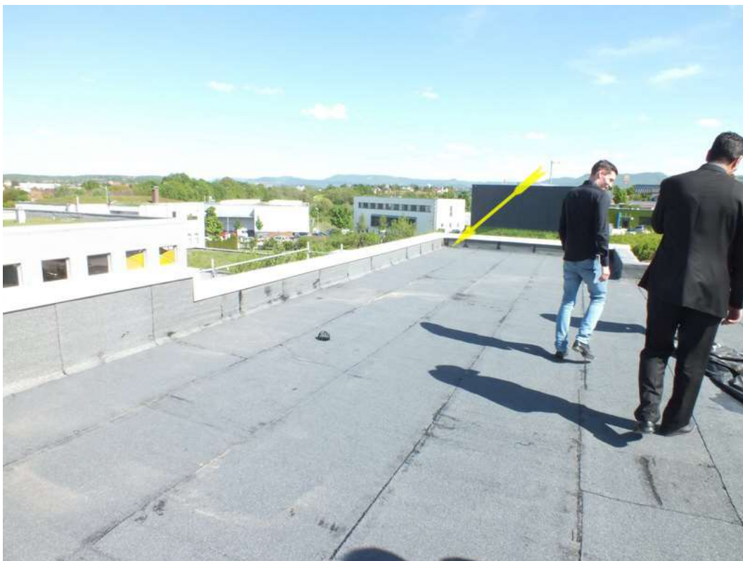
Bild 04_Gewerk Dachdecker Flachdach
