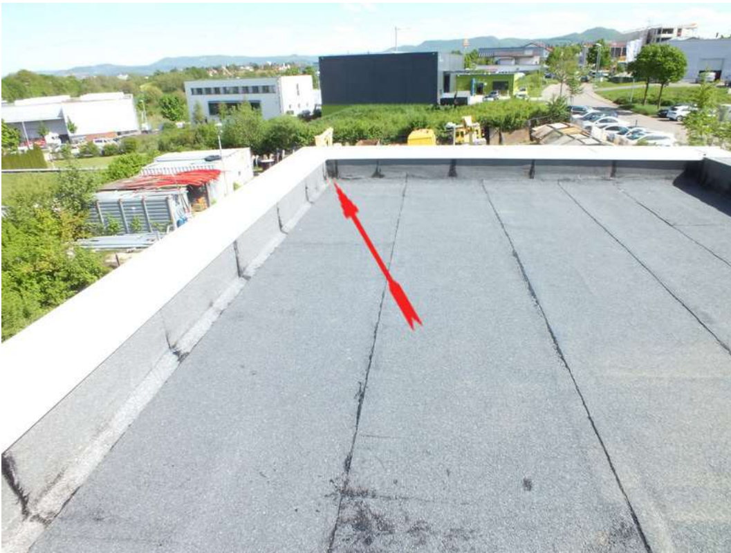
Bild 07_Gewerk Dachdecker Flachdach
