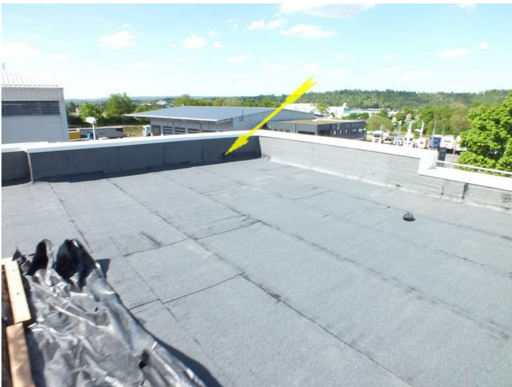
Bild 02_Gewerk Dachdecker Flachdach
