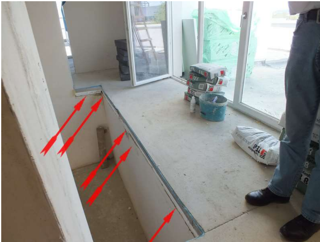
Bild 15_Gewerk Dachdecker Flachdach
