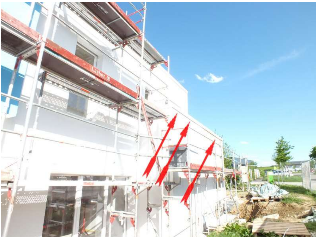
Bild 22_Gewerk Dachdecker Flachdach
