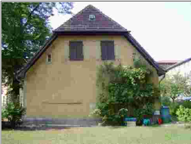
Dachgeschossausbau, Potsdam, H.-Mann-Allee, vorher
