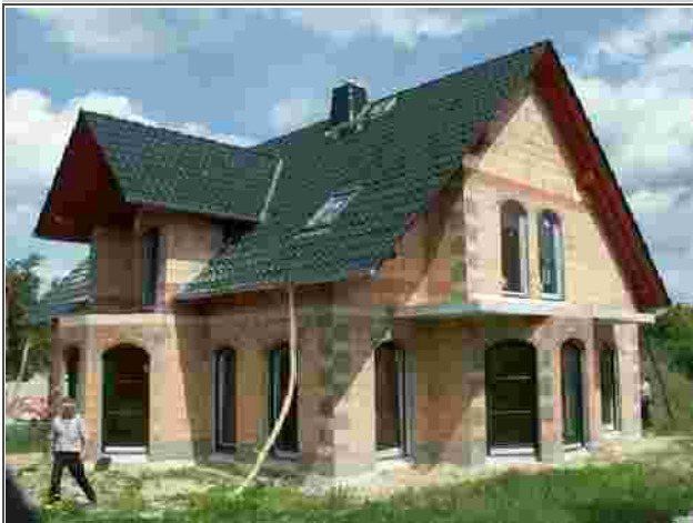
Hinnehbare Mngel an Fassade in Barnewitz
