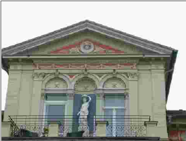
historische Fassade an GrGnderzeitvilla in Potsdam
