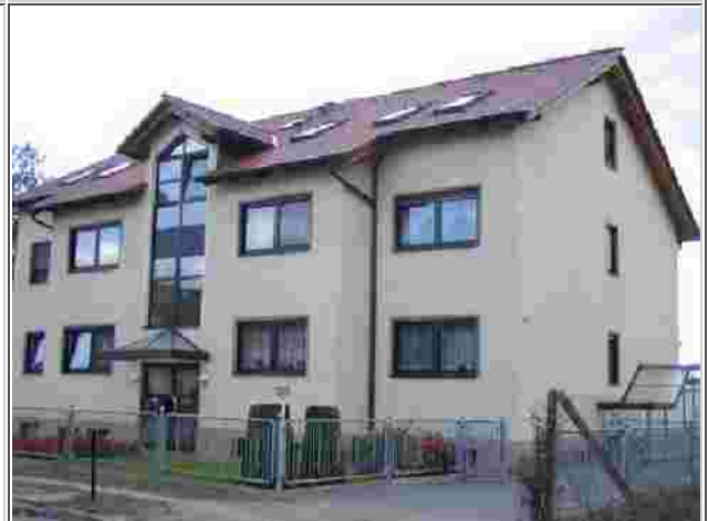
Kellerabdichtung Mehrfamilienhaus in Bestensee
