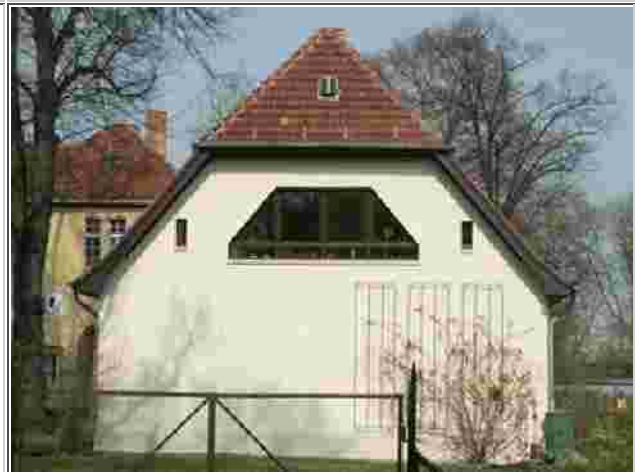
Dachgeschossausbau, Potsdam, H.-Mann-Allee, nachher
